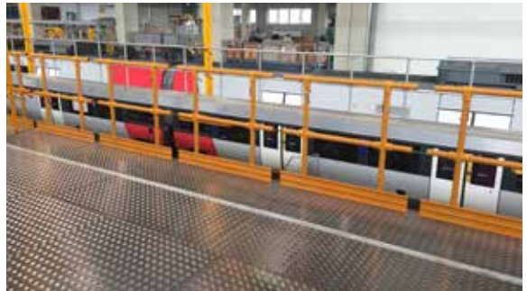
Maintenance hall ÖBB, Innsbruck
