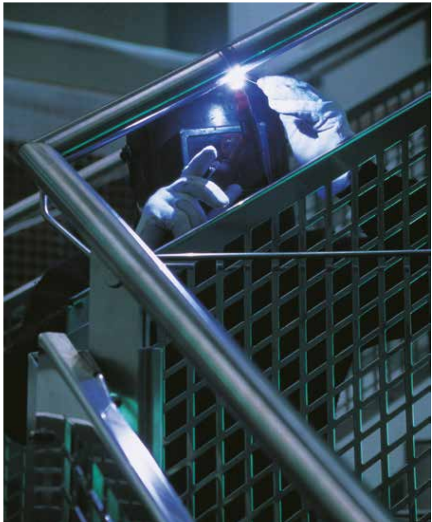
Bild 9: WIG-Schweißen eines Edelstahlgeländers
