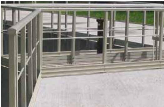
Las barandillas PRFV MEISER se ofrecen en dos modelos distintos, y además pueden conectarse en construcciones tanto horizontales como verticales.
