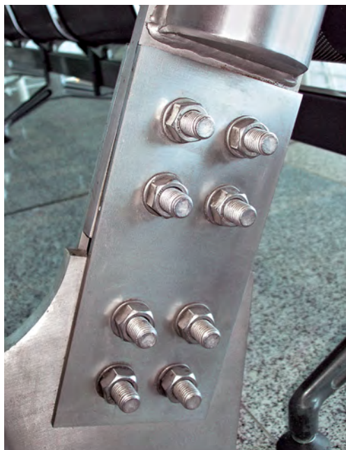
Edelstahl-Teile erfordern Edelstahl-Befestigungsmittel.
