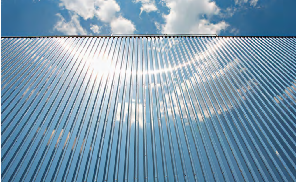
Für die Fassade dieses Industriegebäudes in Siemianowice Śląskie, Polen, wurde der Werkstoff 1.4526 in der blankgeglühten Ausführung 2R gewählt, welche die Selbstreinigung begünstigt. Foto: ArcelorMittal Stainless Europe/A. Zekri
