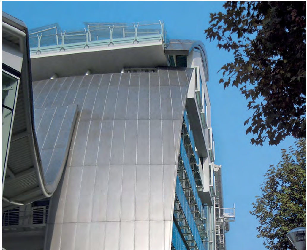
Teile der Gebäudehülle, die der Witterung ausgesetzt sind, werden durch Regenwasser wirksam gereinigt. Foto: Centro Inox, Mailand (I)
