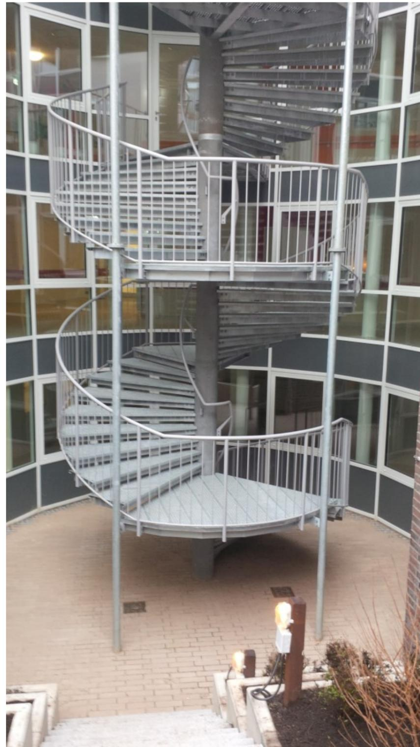
Mit einem Durchmesser von 3750 mm ist dies eine außergewöhnliche Ausführung für eine Spindeltreppe. Die Höhe der Spindeltreppe beträgt 12325 mm. Ein sicheres Auf- und Absteigen der Treppenanlage ist durch die MEISER Blechprofilstufen gewährleistet. Hier kann auf die verschiedensten Blechprofilrostoberflächen anhängig vom Anforderungsprofil zurückgegriffen werden.
