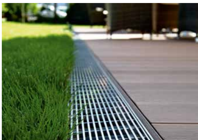
Drainage des terrasses
