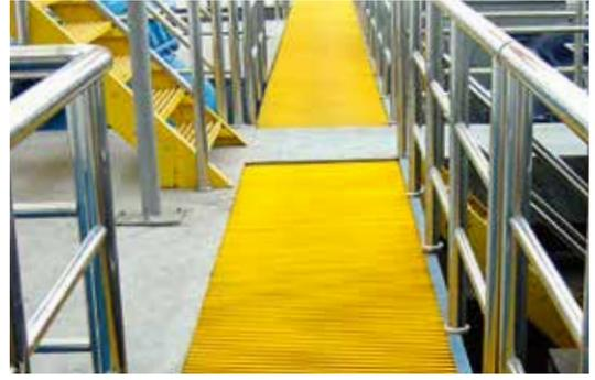
L'alternativa per situazioni gravose ed altezze ridotte. I grigliati pultrusi MEISER in FRP sono costituiti da profili portanti pultrusi attraversati, a distanze predefinite, da barre trasversali.
