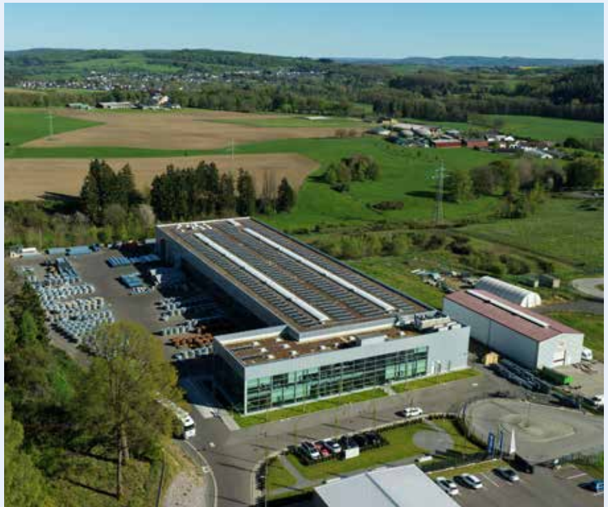
Am Hauptstandort von MEISER Solar in Losheim am See entstehen seit 2024 Montagesysteme für Solarprojekte weltweit
