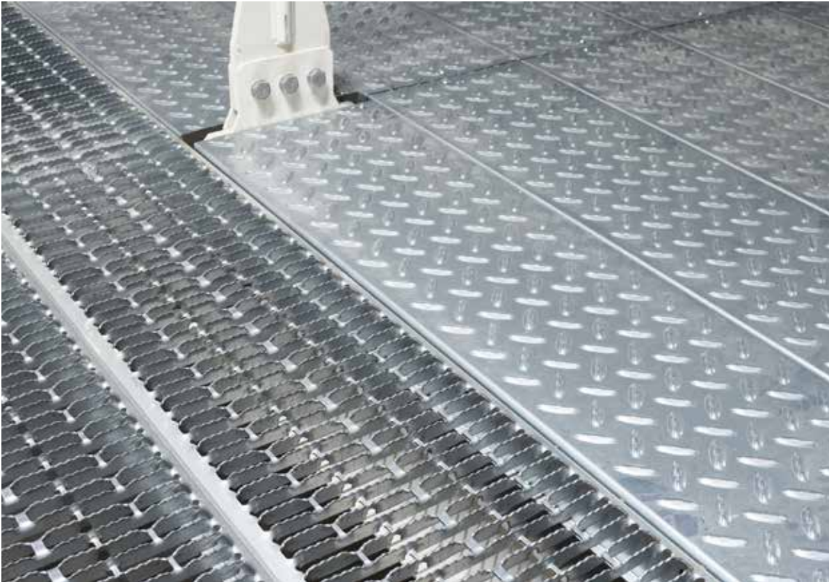
Verschiedene MEISER Blechprofilroste verlegt in einer Fertigungshalle von AUDI
