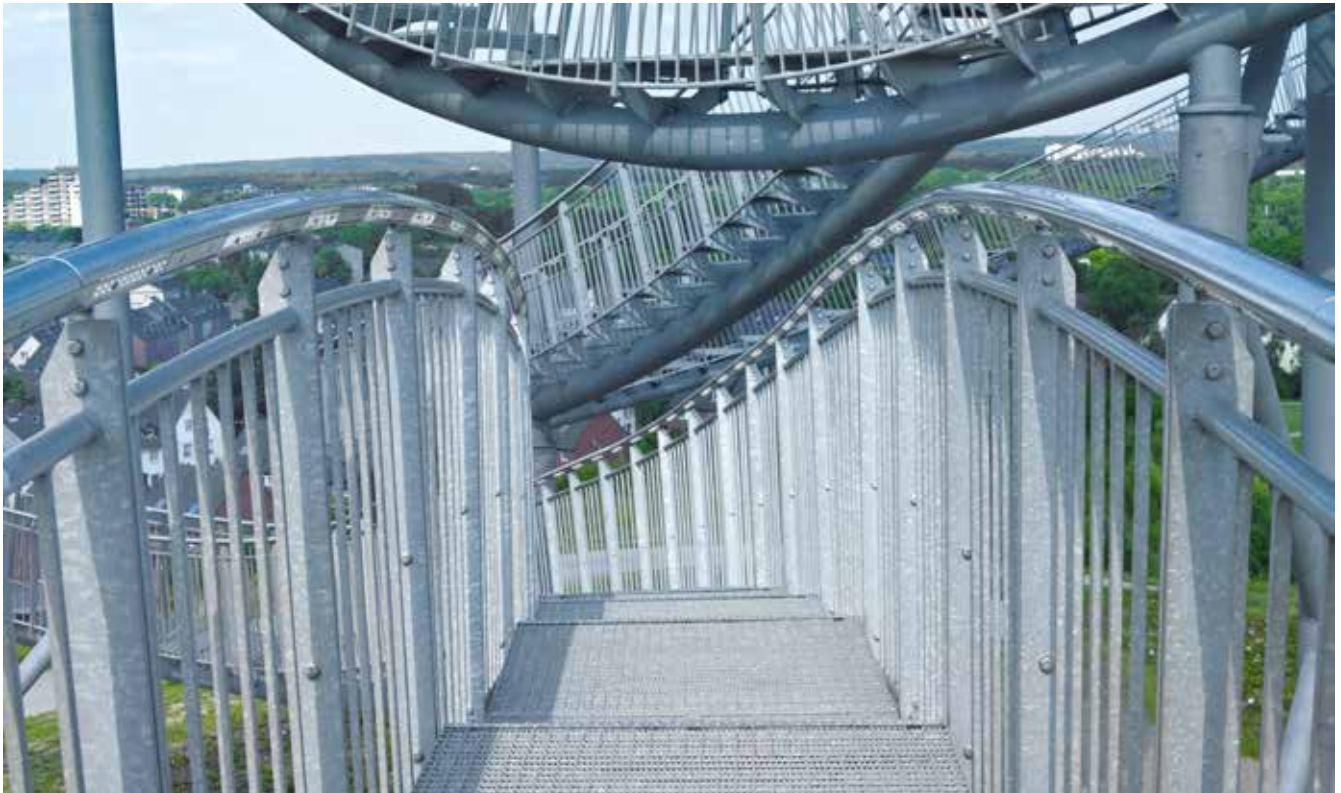
Auf der begehbaren Achterbahn Tiger & Turtle bieten MEISER Pressroste mit Gleitschutz sicheren Tritt in luftiger Höhe
