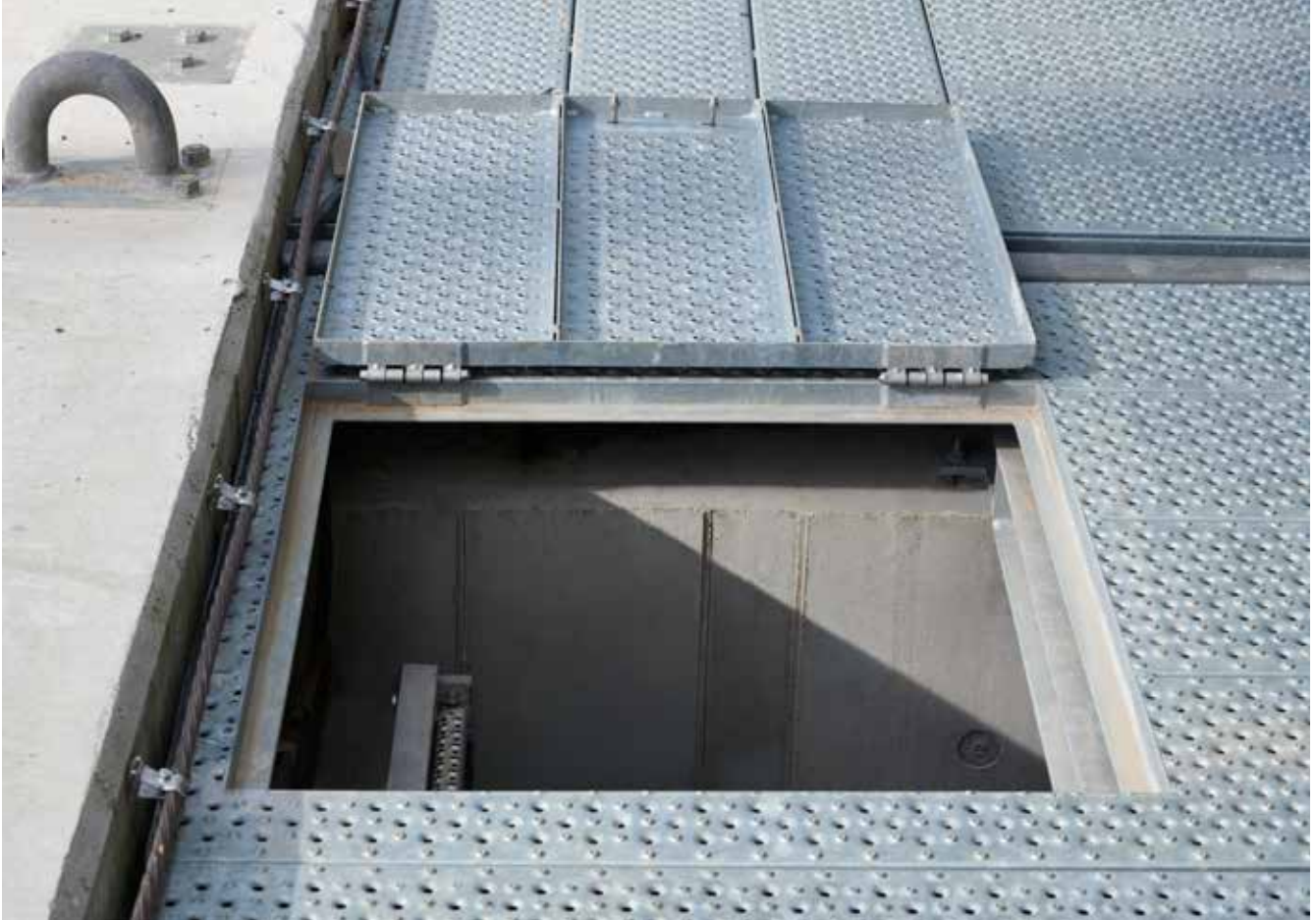
Eine Stephuit FH-Revisionsklappe ist eine Serviceöffnung mit Scharnier, die in unterschiedlichen Größen erhältlich ist
