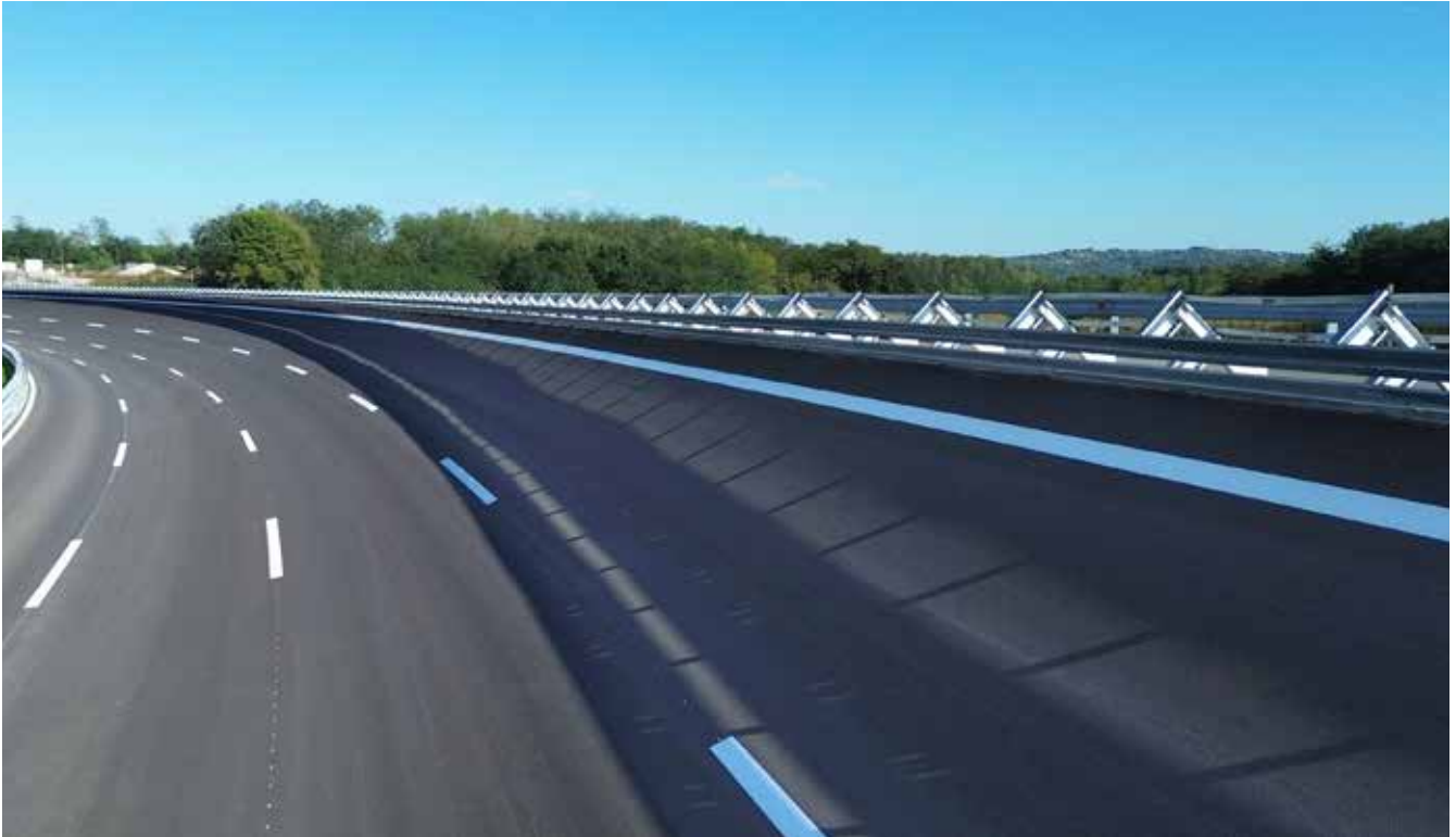
MEISER Road Safety Fahrzeugrückhaltesysteme sichern die anspruchsvollen Teststrecken der AVL ZalaZONE
