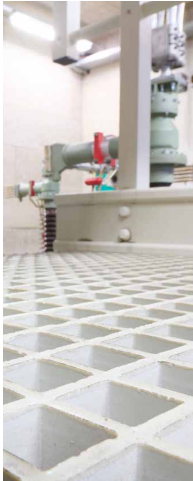
Verlegte GFK-Roste beim Siemens Energy Test Field
