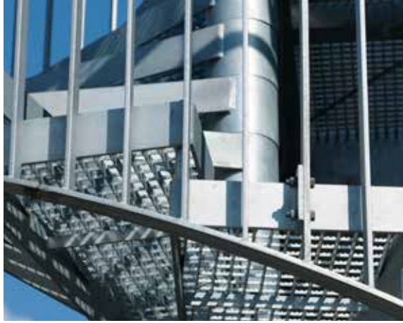
Escaliers hélicoïdaux de l'ensemble résidentiel Anna-Sofien-Höfe à Langen
