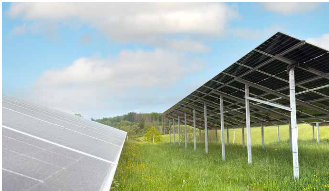
Le système de montage bipode MEISER Portrait dans un parc solaire à Nonnweiler
