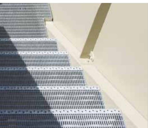
Marches d'escalier en caillebotis pressés à Munich
