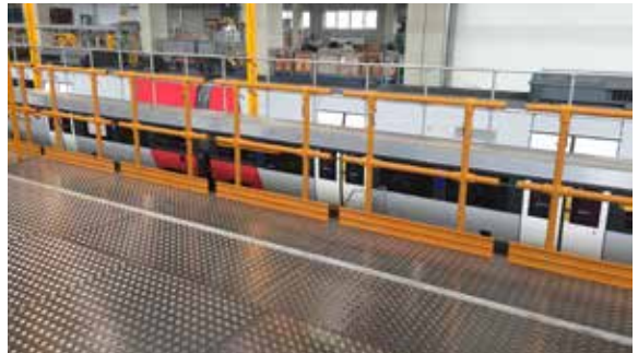
Maintenance hall ÖBB, Innsbruck
